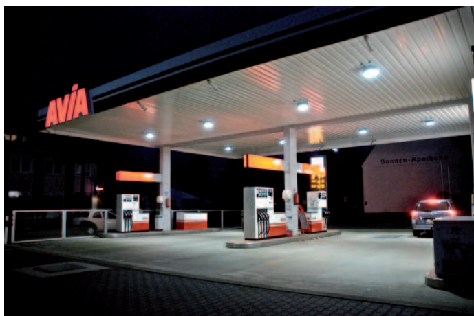
↑ Die Beleuchtung dieser Tankstelle wurde von acht Stück 250-W-Halogenleuchten auf acht LED-Flächenleuchten à 60W umgerüstet.
